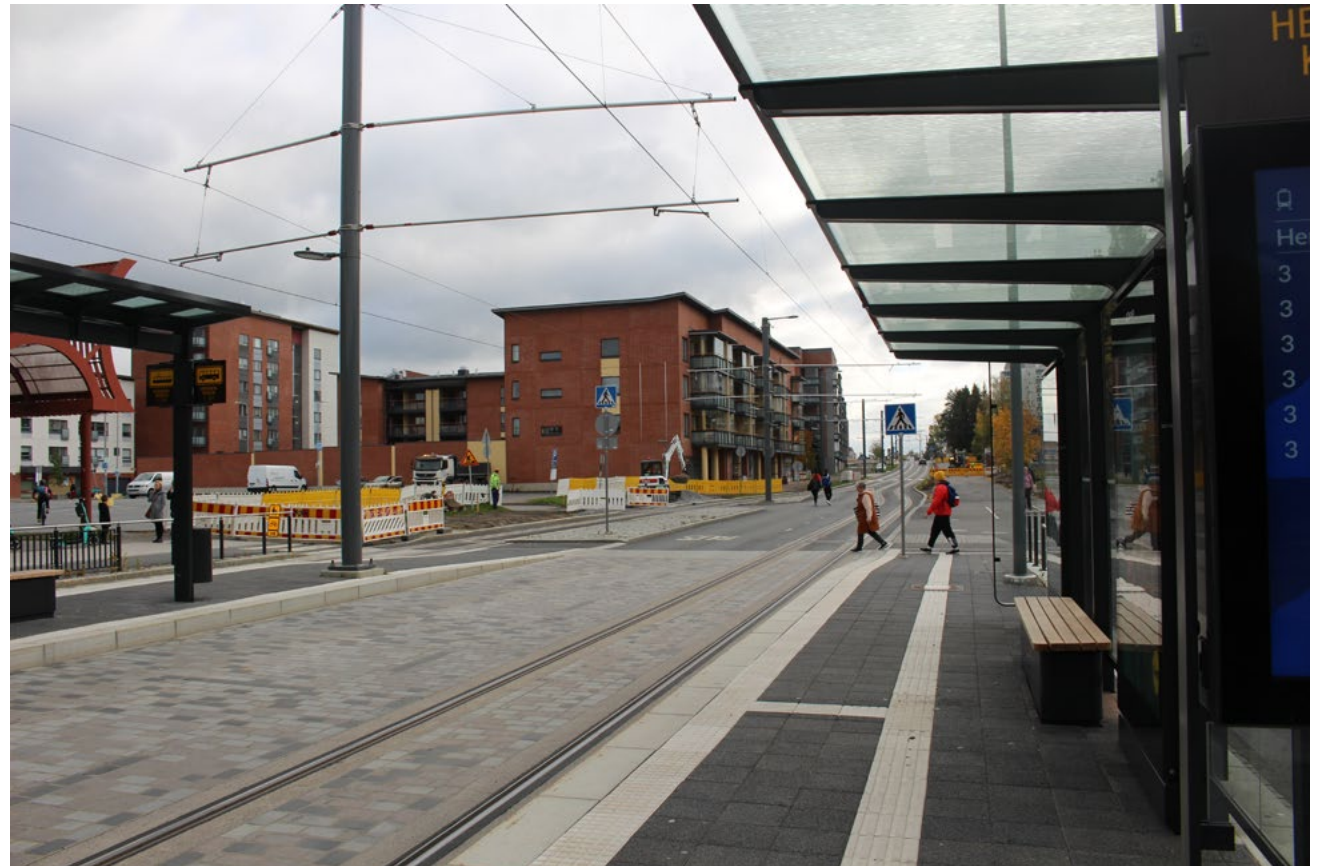
Esimerkki korkean laatutason erityiskohdasta (Hervanta, Tampere): raide pysäkin kohdalta luonnonkivetty
