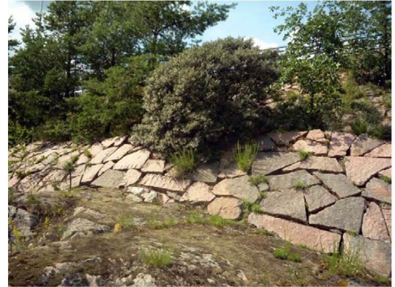
Kuva. Lohkovivellä verhoiltua siltapenkereen terassointia on pehmennetty tyrni-, tervalepö- ja mäntyistutuksilla. Naantali.
